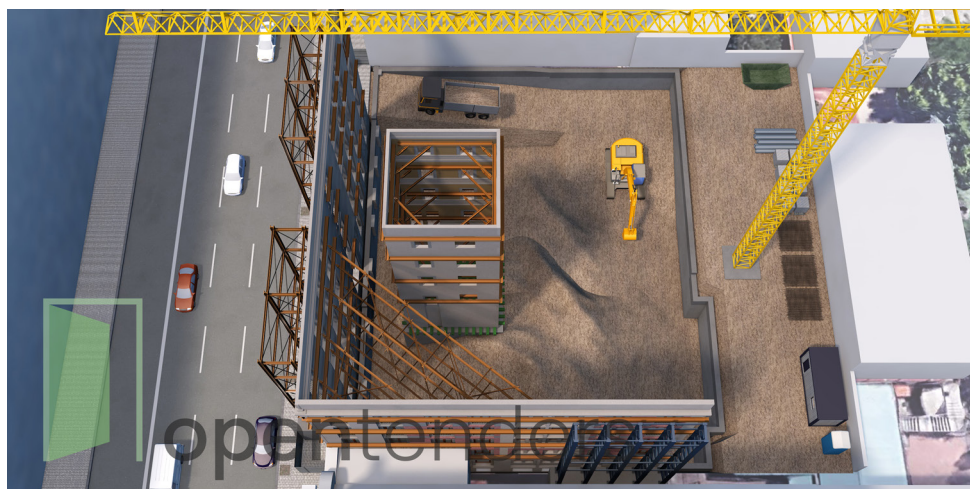
Escavações na reabilitação de edifícios.
